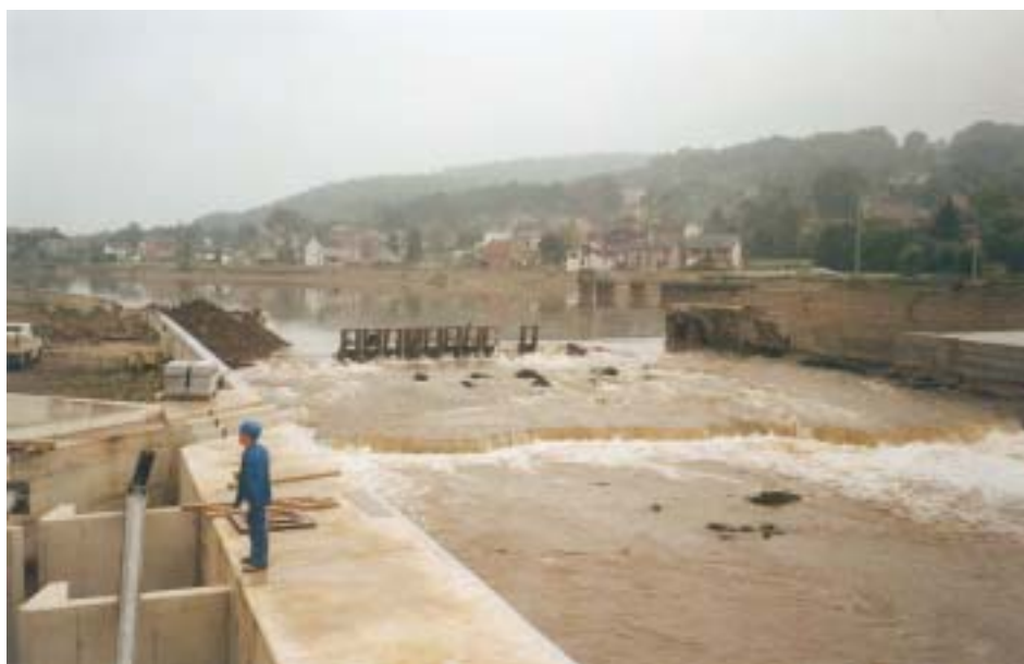
A l'avant plan : construction du nouveau barrage d'Hastière. A l'arrière plan : quelques hausses encore debout.
